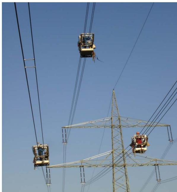
*Abb. 10: Montage der Feldbündelabstandhalter mit Fahrwagen*
