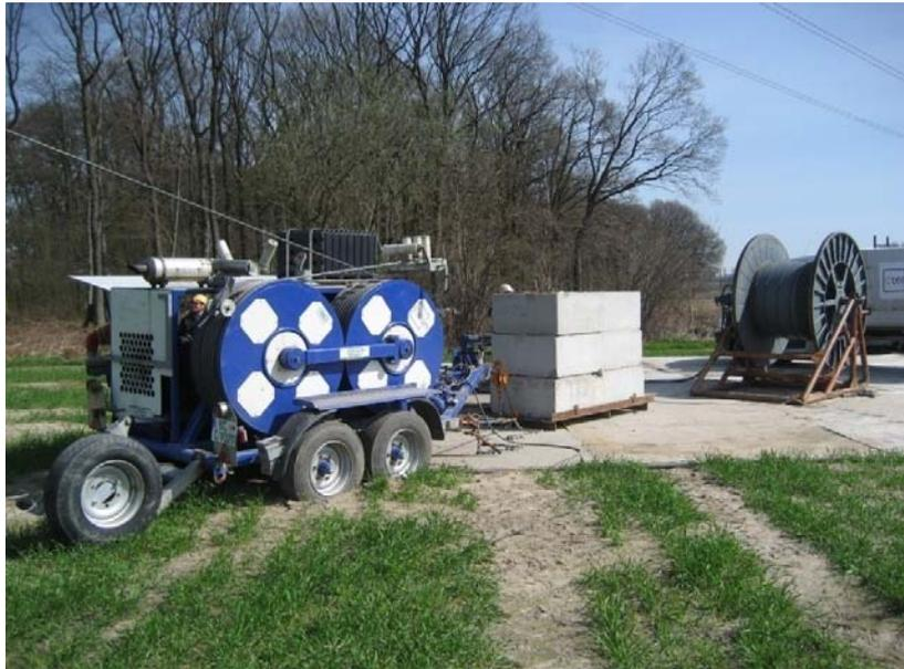
*Abb. 9: Windenplatz eines 4er-Bündel-Seilzuges*
