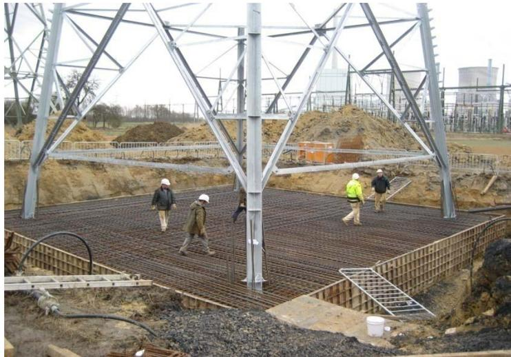
*Abb. 3: Montage der Fundamentbewehrung*
