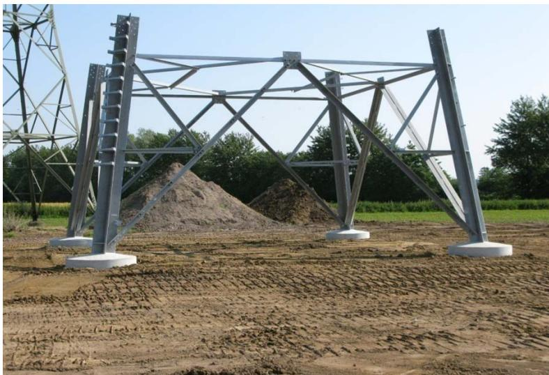
*Abb. 5: Montierter Mastfuss*
