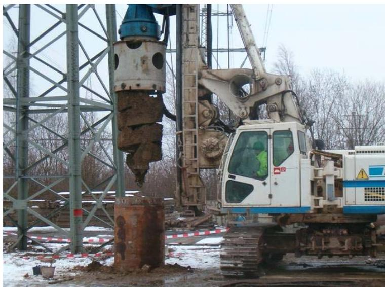
*Abb. 4: Bohrung für einen Bohrfahl*
