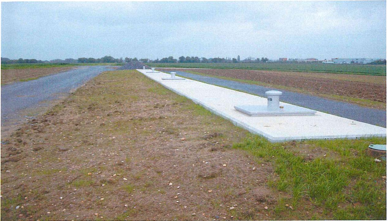
Beispielhafter oberirdischer Abschluss Versickerungsschlitz
