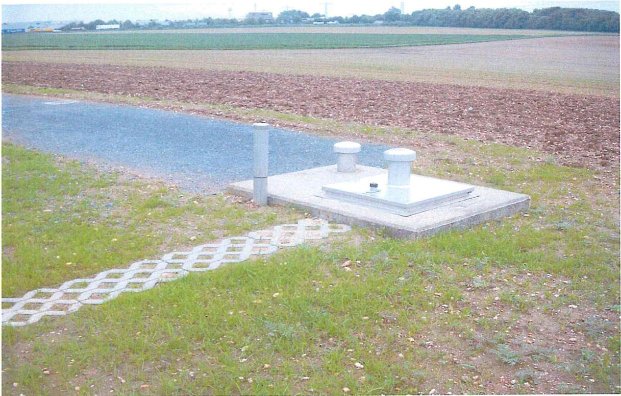
Beispielhafter oberirdischer Abschluss Reinfiltrationstechnik
