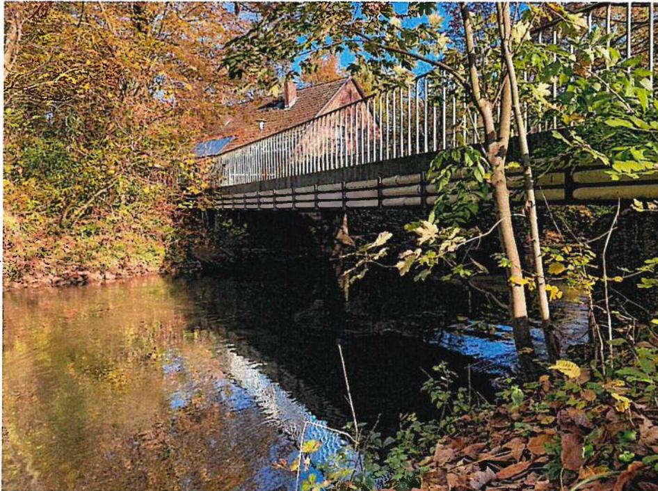
Abb. 4: abgehendes Brückenbauwerk und Uferbereiche mit Steinschüttungen
