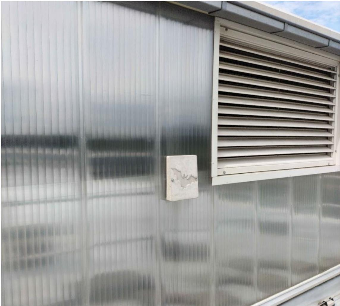
**Abbildung 4** An Hohlkammerplatte installierte Wandschale
