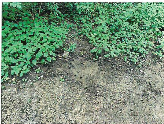
Abbildung 18: Schacht 4564097 im Detail
