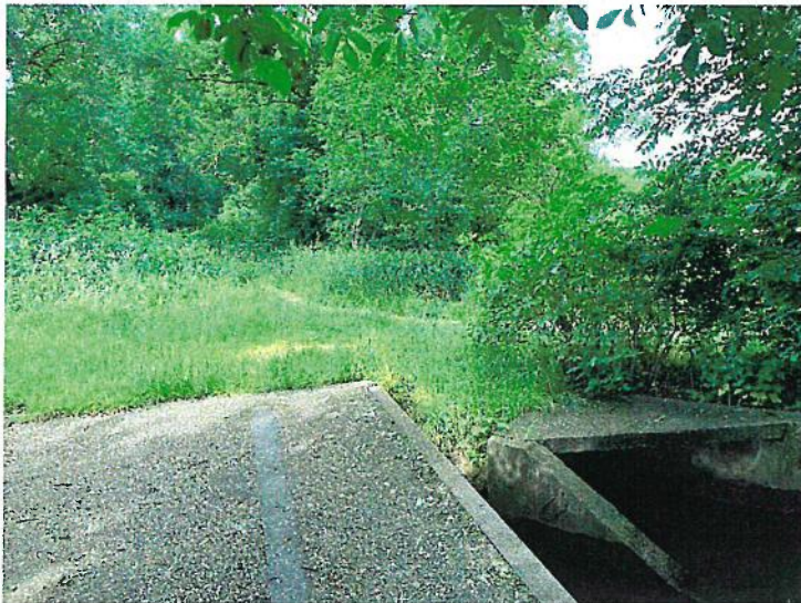
Abbildung 5: Blick auf die derzeitige Einleitstelle (Richtung Westen)
