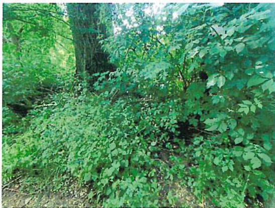
Abbildung 22: Schacht 4564099 im Detail
