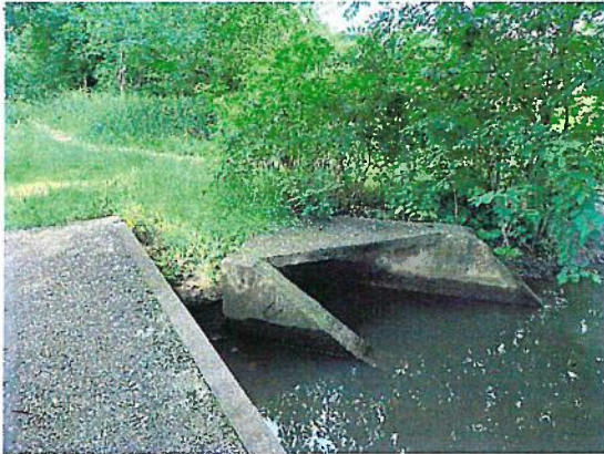
Abbildung 26: Einleitstelle; Blickrichtung Osten
