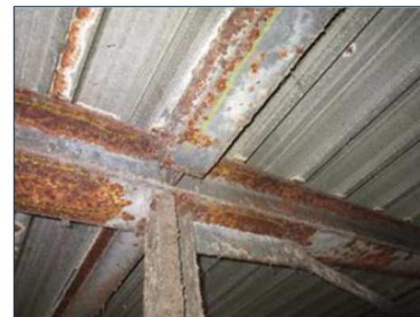
Flächige Korrosion
