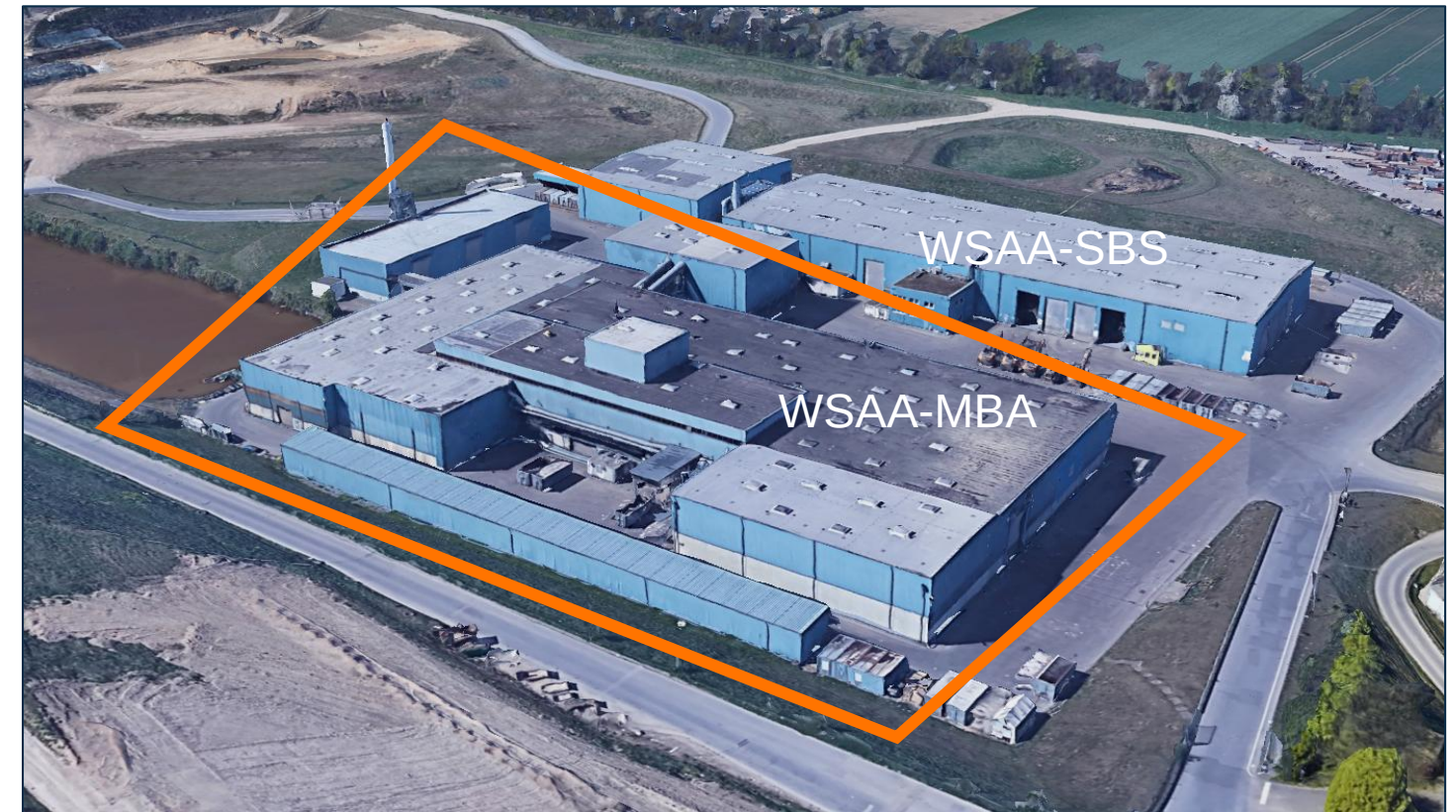
Mechanisch-biologische Abfallbehandlungsanlage (WSAA-MBA)
