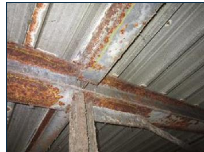
Flächige Korrosion
