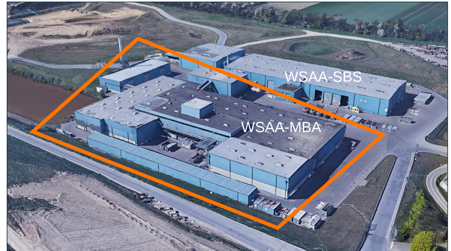
Mechanisch-biologische Abfallbehandlungsanlage (WSAA-MBA)
