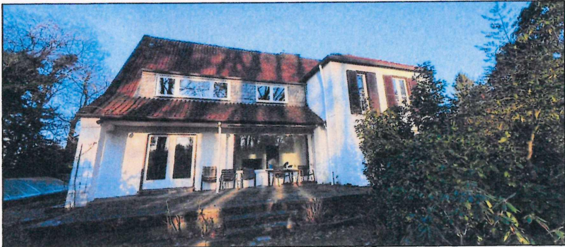
Abb. 2: Rückseite des Gebäudes.
