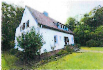
EINGANGSSEITE (BLICK VON NORDEN)
