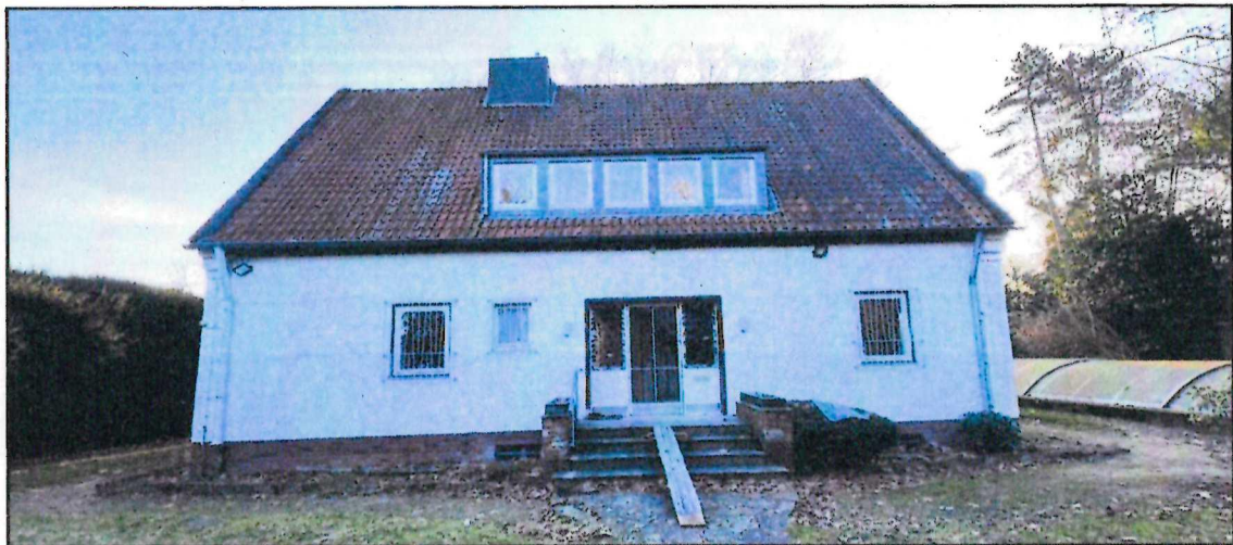
Abb. 1: Das zweistöckige Wohngebäude von der Vorderseite aus gesehen.
