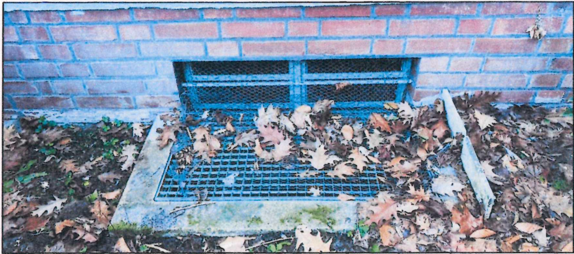
Abb. 6: verschlossenes und mit Hasendraht gesichertes Kellerfenster.
