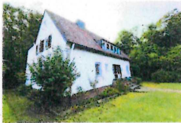
EINGANGSSEITE (BLICK VON NORDEN)
