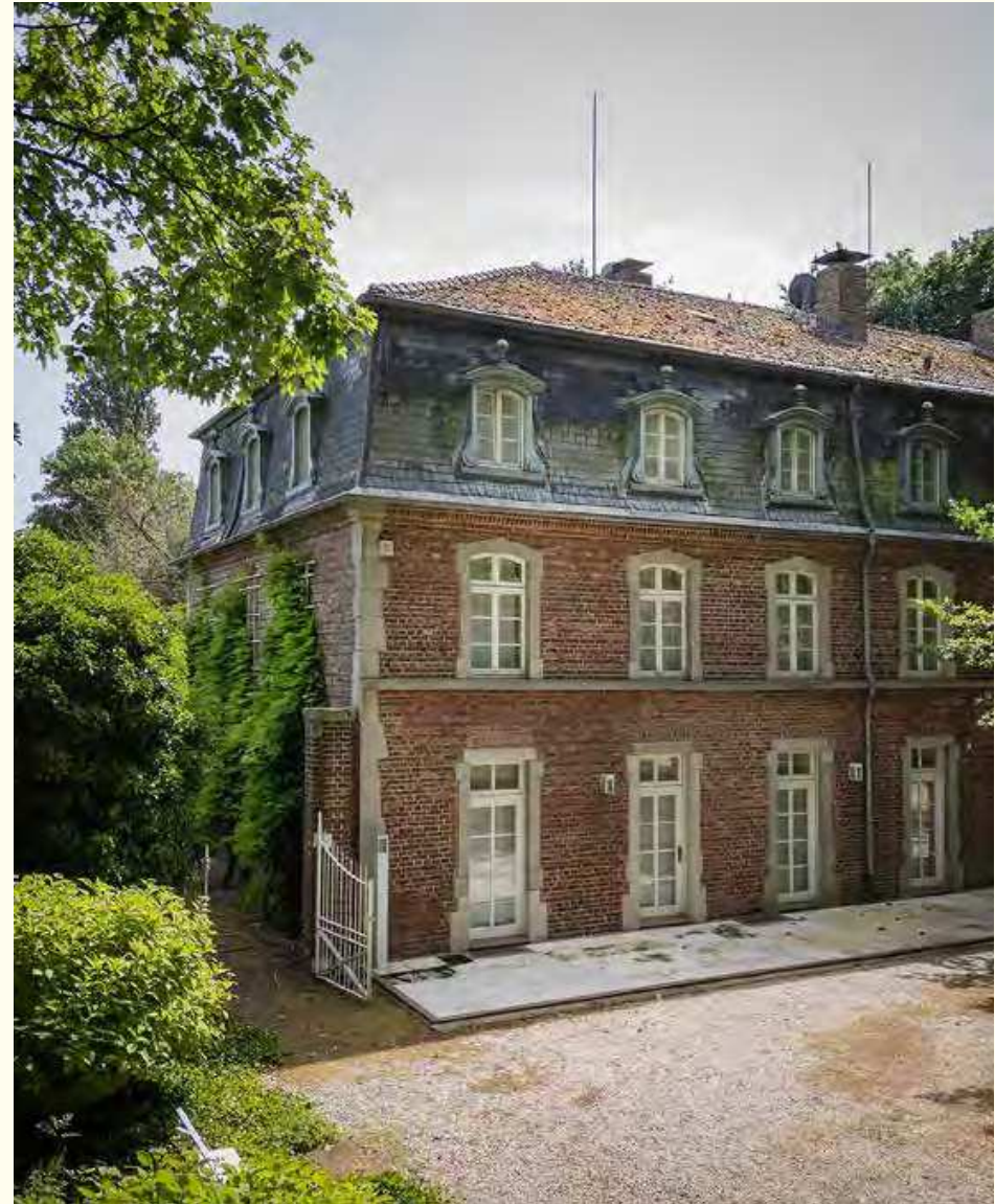
Seltlicher Zugang zum ehemaligen Gutsvorwerkhaus
