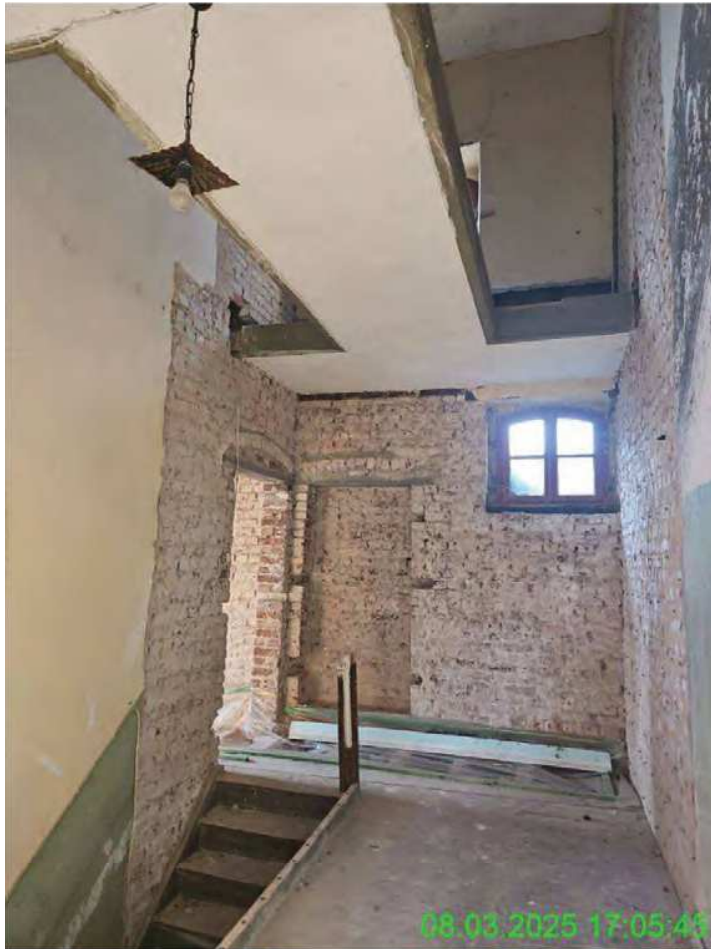
Westflügel: Entfernte Holztreppe wg. Hausschwammbefall
