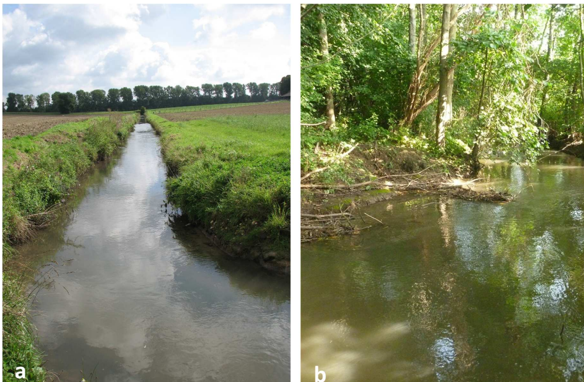
Abbildung 3: a) Ausgebauter Gillbach bei Evinghoven; b) Renaturierter Abschnitt bei Evinghoven (Fotos: Erftverband)
