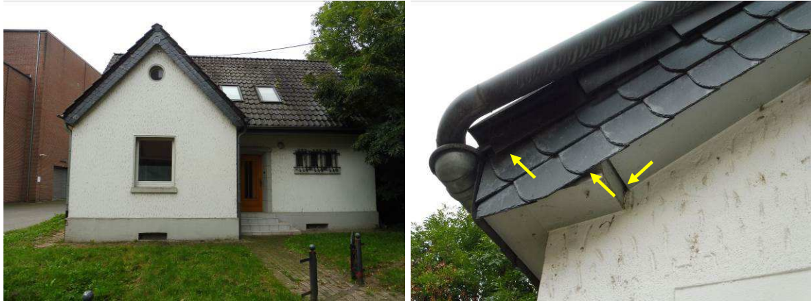
Abb.5: Artenschutzrechtlich ggf. relevante Strukturen an dem Abbruchgebäude auf dem Grundstück Erprather Mühle in Neuss-Weckhoven.
