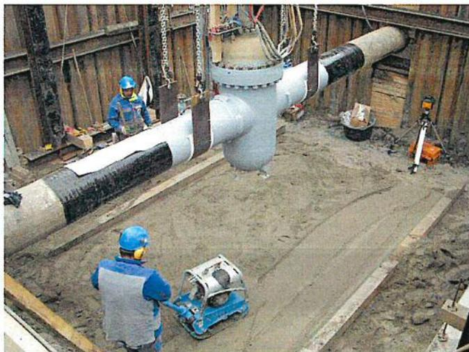
Baugrube mit aufgehängtem Streckenschieber nach Abbruch der alten Auffangwanne, teilweise mit Berliner Verbau
