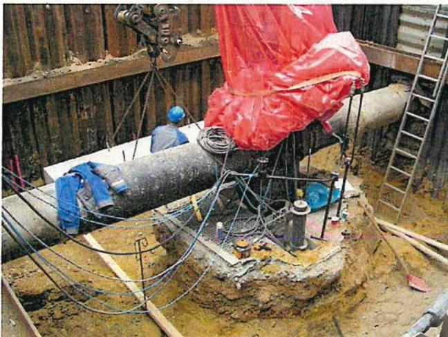
Bauzustand kurz bevor die Ölsonde in die kohlenwasserstoffbeständige Folie umgesetzt wird, welche um den Schieber herum geschlossen wird.
