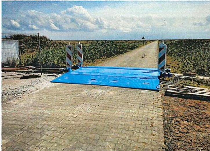
Beispiel einer befahrbaren Schlauchbrücke und zur Überführung einer Entwässerungsleitung
