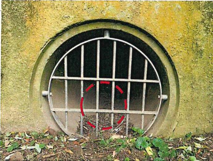
Bild eines Siebes, welches an beiden Seiten des Durchlassbauwerks eingebaut ist. In rot ist eine denkbare Aussparung für die Entwässerungsleitung eingezeichnet.
