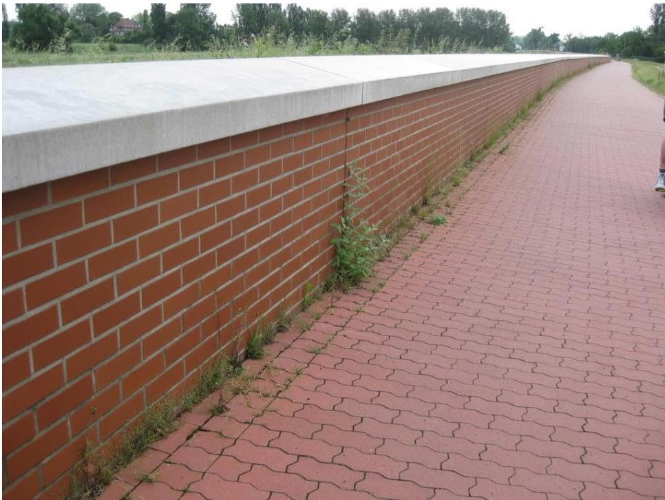
Abbildung 4: Beispiel einer verklinkerten Hochwasserschutzmauer
