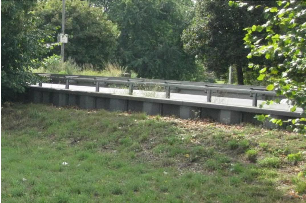
Abbildung 5: Beispiel einer lackierten Spundwand (an der B9)
